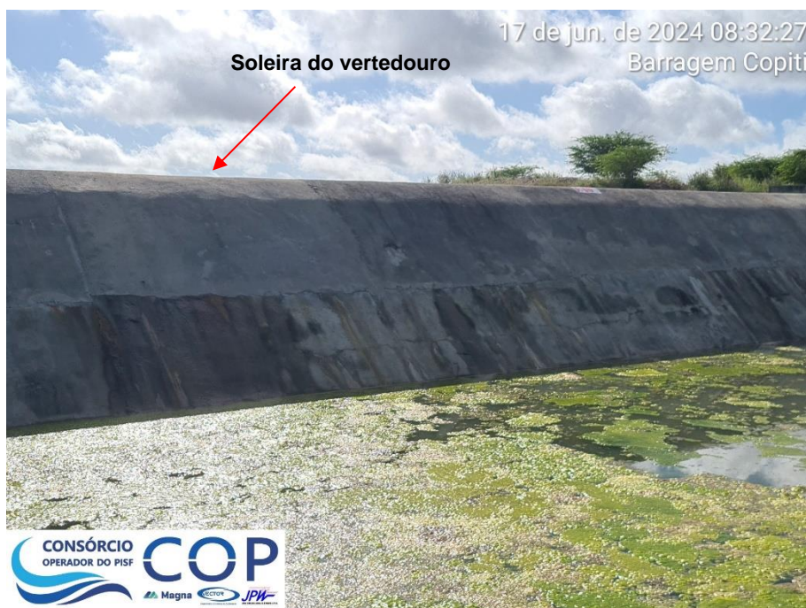
Foto 6.25: Vista longitudinal da soleira do vertedouro, apresentando fissuras, mal acabamento do concreto.
