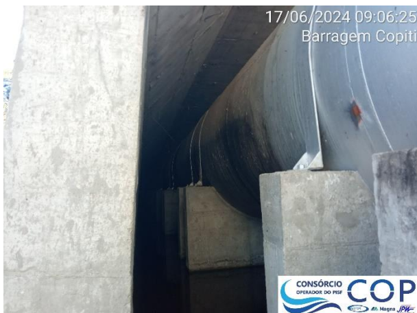
Foto 6.40: Surgência de água no interior da galeria e sinais de corrosão na tubulação.
