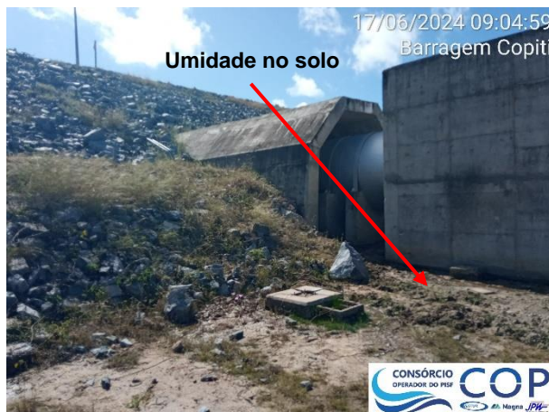
Foto 6.41: Surgências de água junto a saída da galeria da tomada d'água e solo úmido ao seu entorno.
