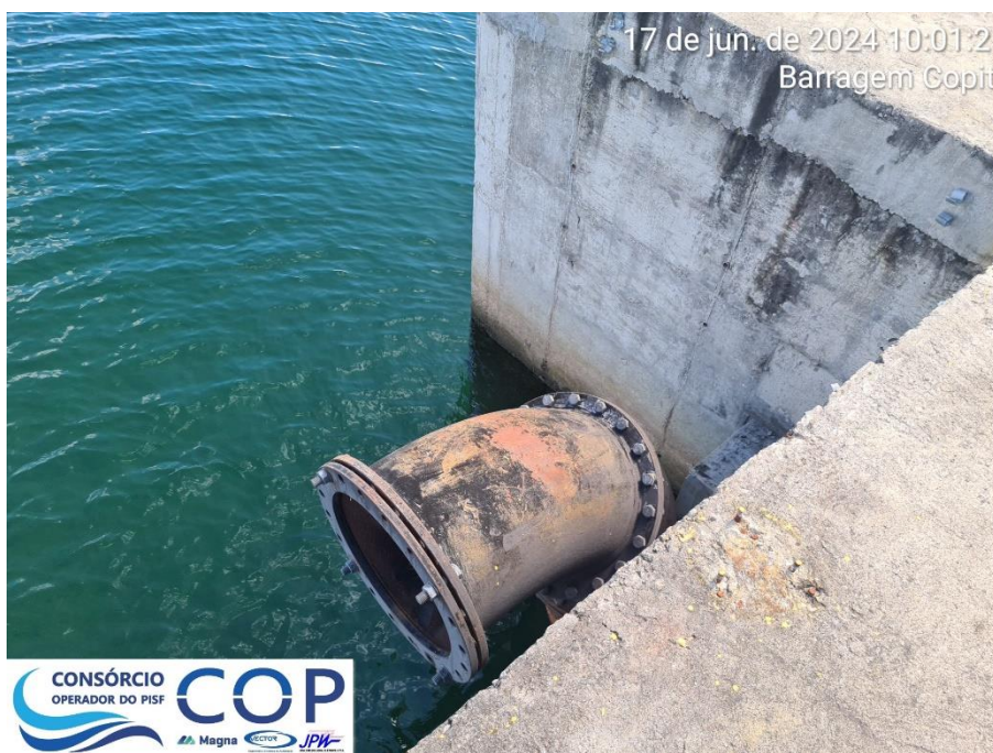
Foto 6.33: Vista da tubulação de ventilação com sinais de corrosão e tela danificada.
