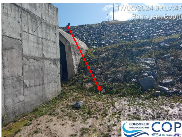
Foto 6.42: Surgências de água junto a saída da galeria da tomada d'água e solo úmido ao seu entorno.
