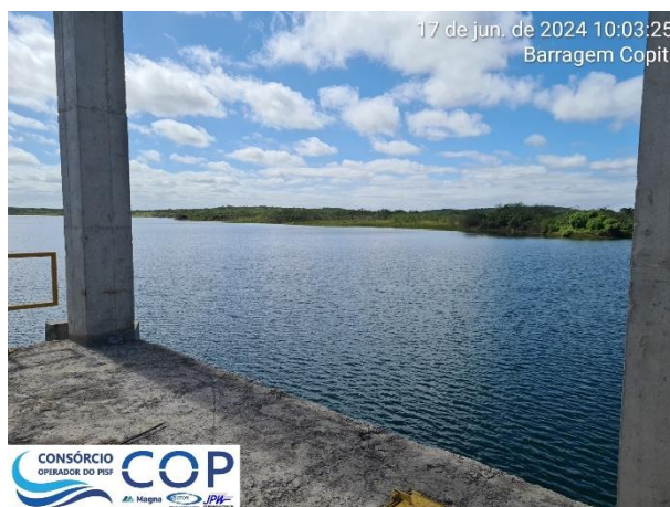
Foto 6.37: Falta de grade de proteção na torre da tomada d'água.
