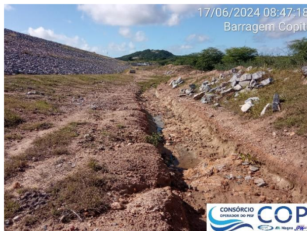
Foto 6.14: Presença de valeta de drenagem entre as estacas 24+00 e 51+00.
