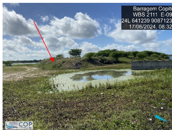
Foto 6.24: Processo erosivo nas paredes naturais do canal de aproximação do vertedouro, lado esquerdo.
