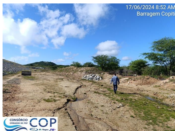
Foto 6.11: Surgências de água na região a jusante – Entre as estacas E 35+00 e 45+00.
