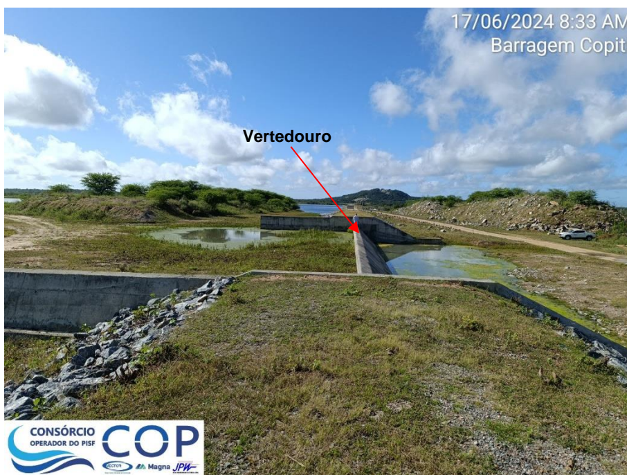
Foto 6.31: Falta de guarda-corpo nos muros laterais esquerdo e direito do vertedouro.
