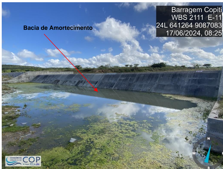
Foto 6.26: Bacia de amortecimento do vertedouro.
