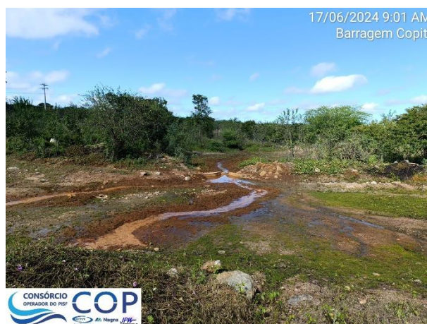
Foto 6.10: Surgências de água na região a jusante – Entre as estacas E 46+00 e E-48+00.
