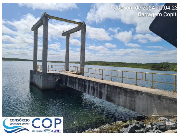
Foto 6.36: Falta de grade de proteção na passarela de acesso à torre da tomada d'água.
