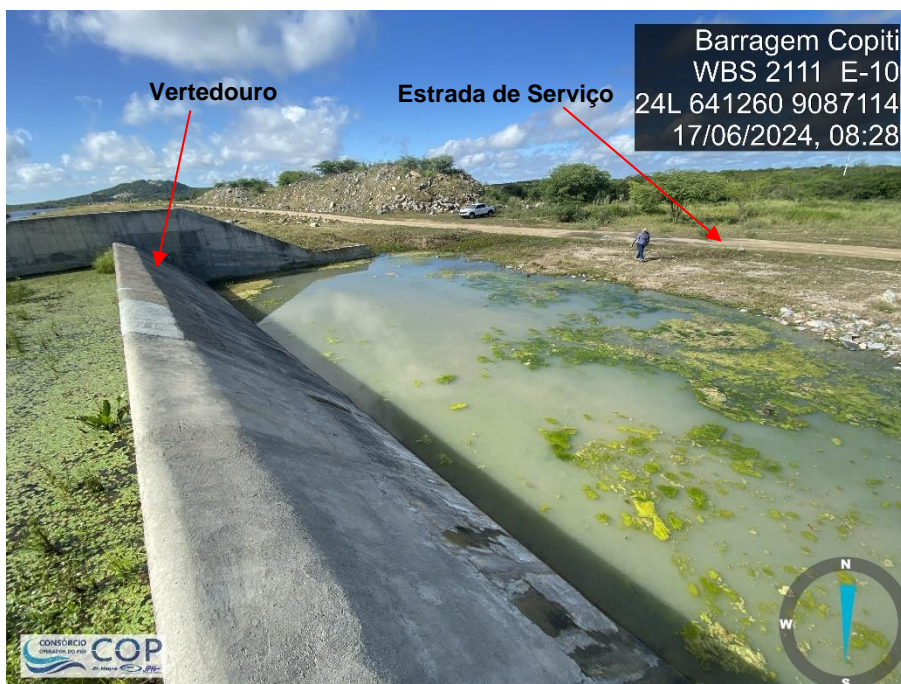
Foto 6.22: Estrada de serviço intercepta o canal de restituição do vertedouro.
