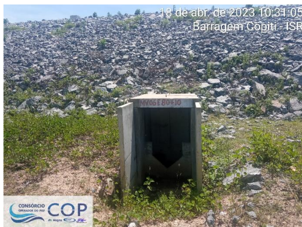
Foto 6.20: Medidor de vazão MV-06 estaca E-80+10.
