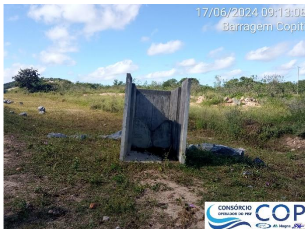
Foto 6.18: Caixa de Medidor de vazão, disposta a jusante da barragem. Provavelmente do MV-04, que não se encontra instalado.
