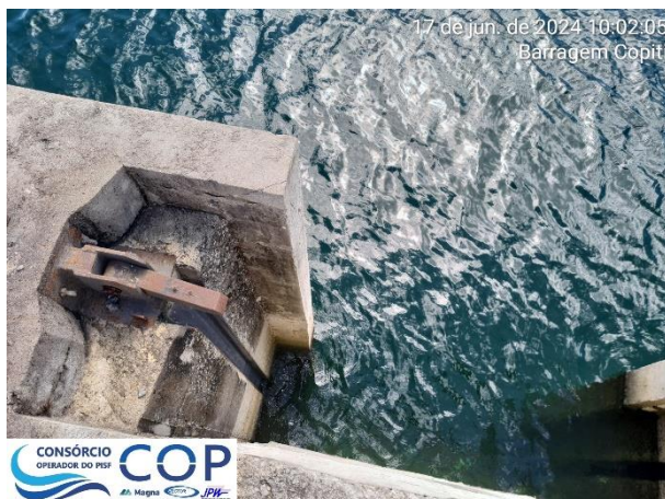
Foto 6.38: Guia de descida da comporta necessitando de correção na pintura.
