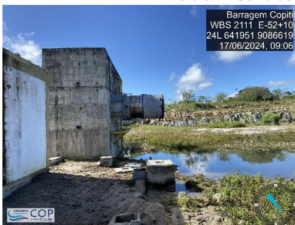
Foto 6.45: Sinais de desgaste na pintura da válvula dispersora.
