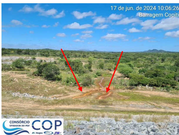
Foto 6.9: Surgências de água na região a jusante – Entre as estacas E-46+00 e E-48+00.
