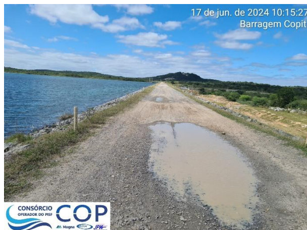
Foto 6.6: Vista do coroamento da barragem, com acúmulo de água em alguns pontos.
