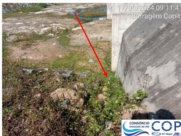
Foto 6.43: Pequena surgência sem carreamento de material, no contato galeria/aterro na região à esquerda da saída da tomada d'água.
