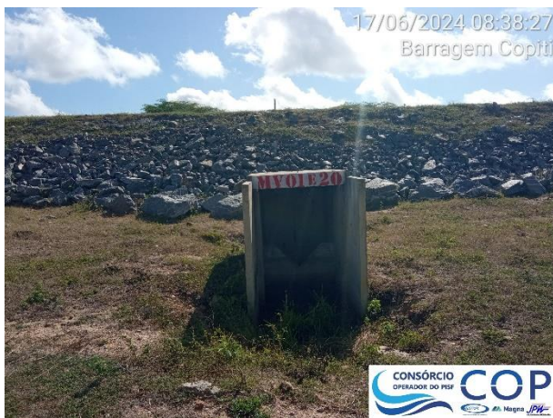
Foto 6.15: Medidor de vazão MV-01 estaca E-20+00.
