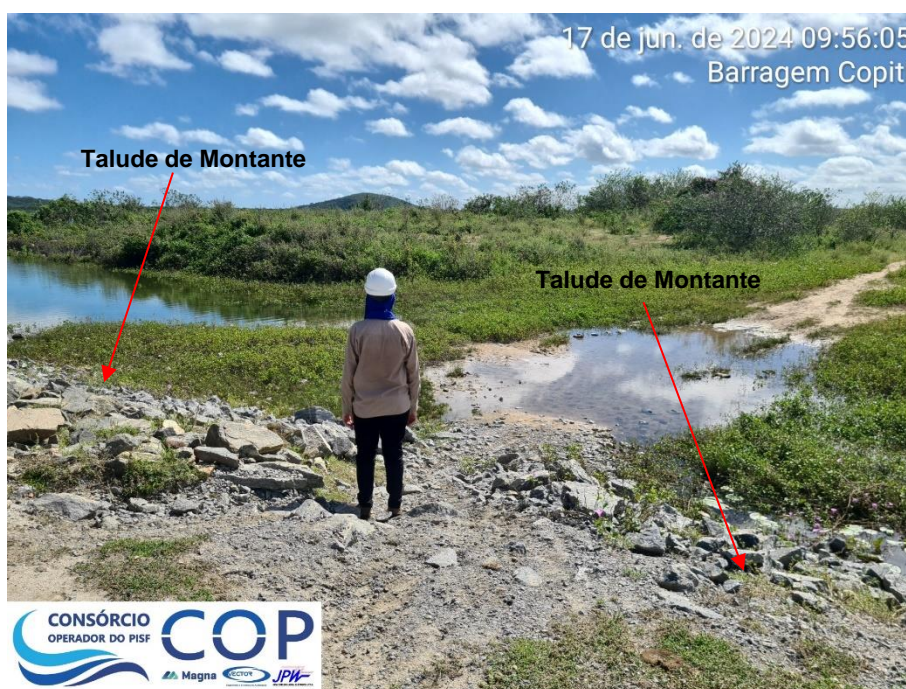
Foto 6.3: Deslocamento do material de proteção do talude de montante – Estaca 63+00, devido a passagem de motocicletas e animais.
