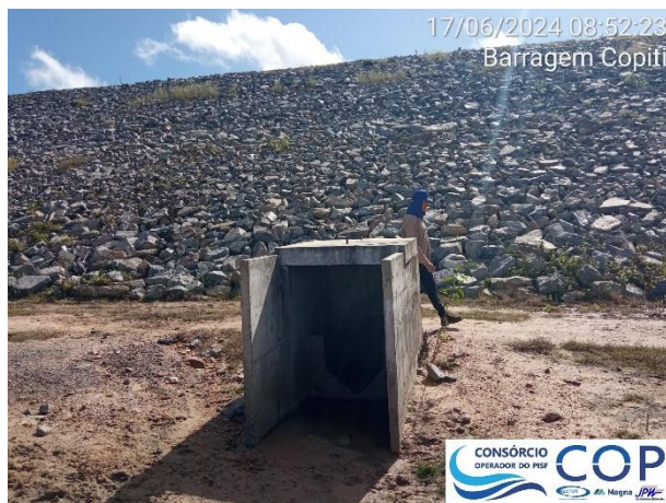
Foto 6.16: Medidor de vazão MV-02 estaca E-40+00.
