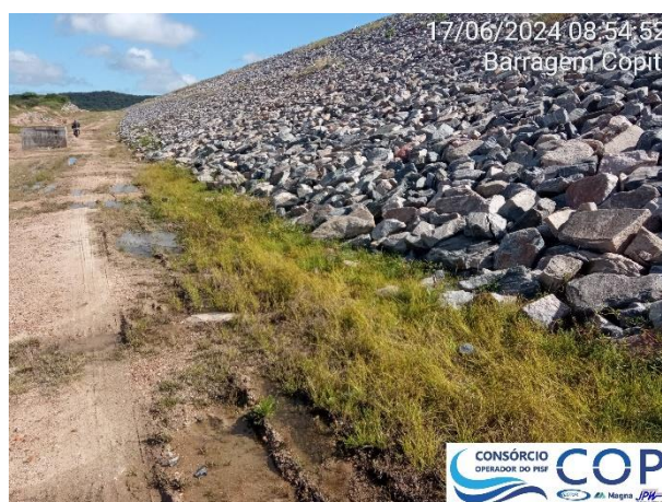
Foto 6.12: Surgências de água na região a jusante – Entre as estacas E 35+00 e 45+00
