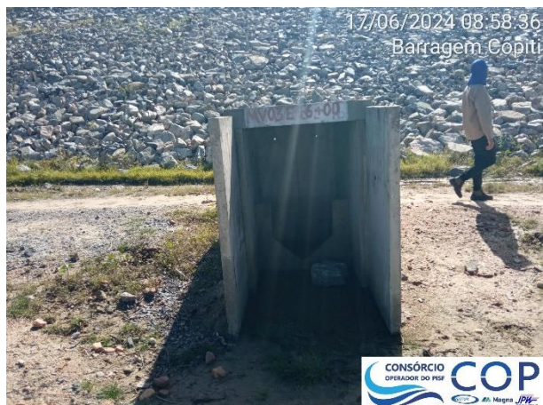
Foto 6.17: Medidor de vazão MV-03 estaca E-46+00.
