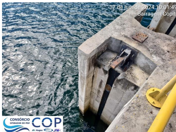
Foto 6.39: Guia de descida da comporta necessitando de correção na pintura.
